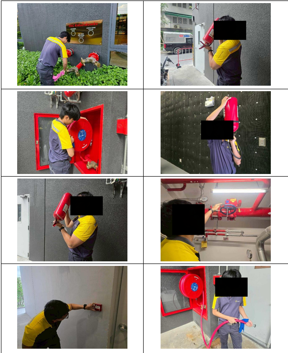
รูปที่ 39 เจ้าหน้าที่ตรวจสอบระบบป้องกันอัคคีภัย
