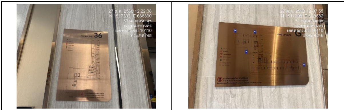
รูปที่ 40 ป้ายแผนผังเส้นทางหนีไฟ
